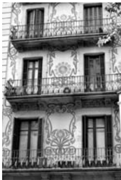
Fig. 59. Fachada modernista en Barcelona.
