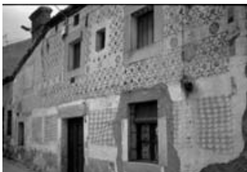
Fig. 81. Fachada en Valleruela de Sepúlveda (Segovia).
