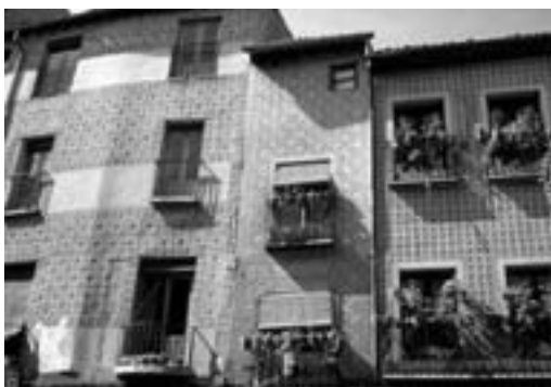
Fig. 83. Fachadas en la Calle Real de Segovia
