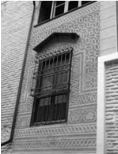
Fig. 7. Esgrafiado antiguo totalmente restituido en Toledo.
