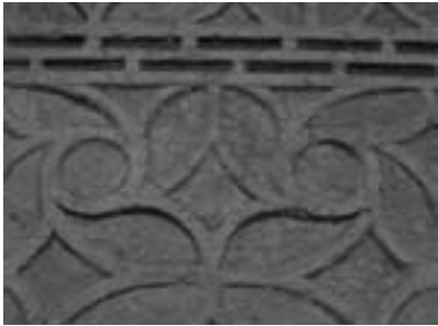
Fig. 5. Detalle de la Torre de Arias Dávila. Ornamentación.
